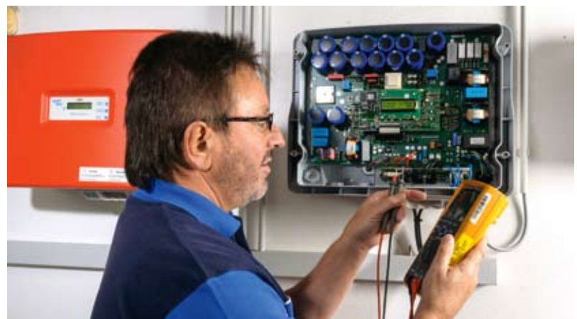
Die Wechselrichter sind das Herzstück einer PV-Anlage. Eine Option ist es, die Technik gegen innere Betriebsschäden zu versichern.
